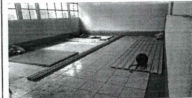
Foto 4: En proceso la sustitucion del pisos del aula No. 3
