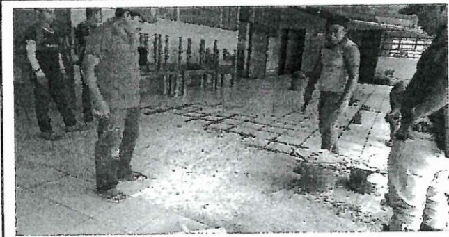
Foto1: en proceso la sustitucion de las partes dañadas del corredor
