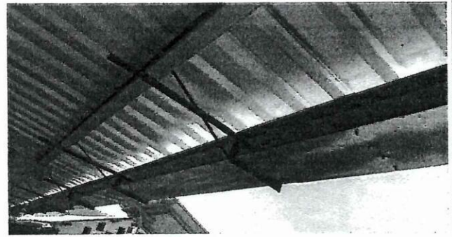
Foto7: en proceso de la colocacion de canal con metal.
