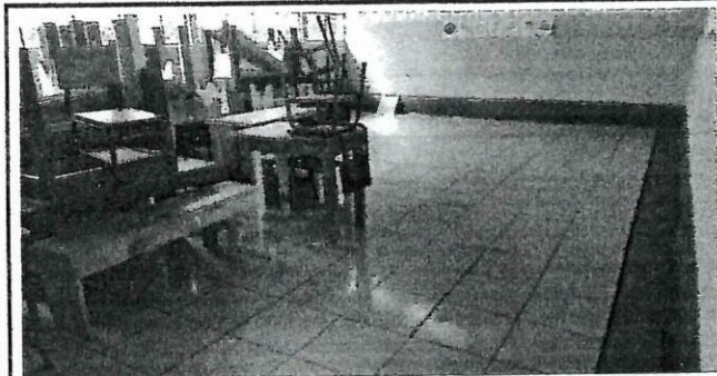
Foto 3: en proceso la sustitucion del aula No. 02
