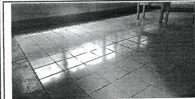
Foto 5: En proceso la sustitucion de los pisos rajados en el aula No. 4
